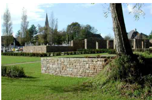
Gestion des niveaux grâce à des murets de pierre
