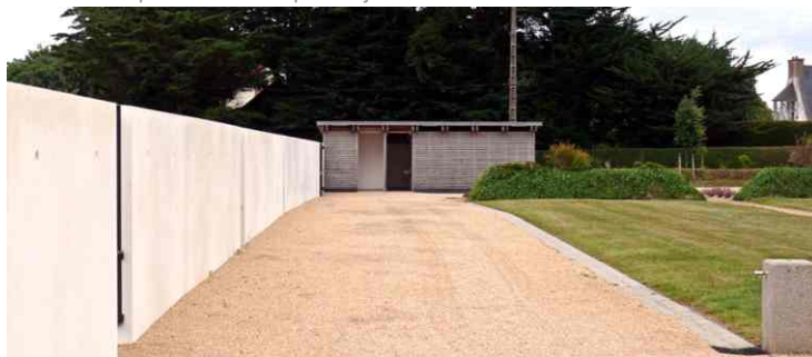
Espace d'accueil gravillonné
